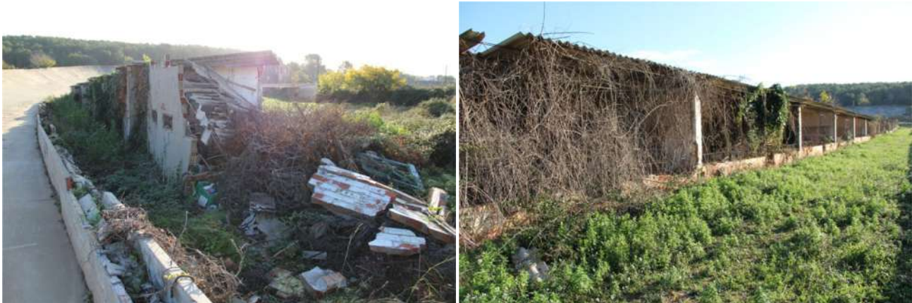
Imatge 50. Estat de les edificacions de l'antiga explotació agrícola
