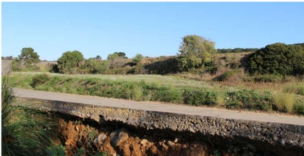
Imatge 27. Acumulacions de terra a l'interior del circuit
