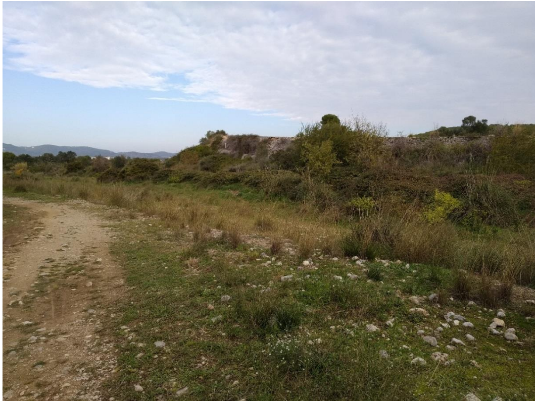
Fotografia 1. Detall del mur de contenció exterior a la zona de la riera
