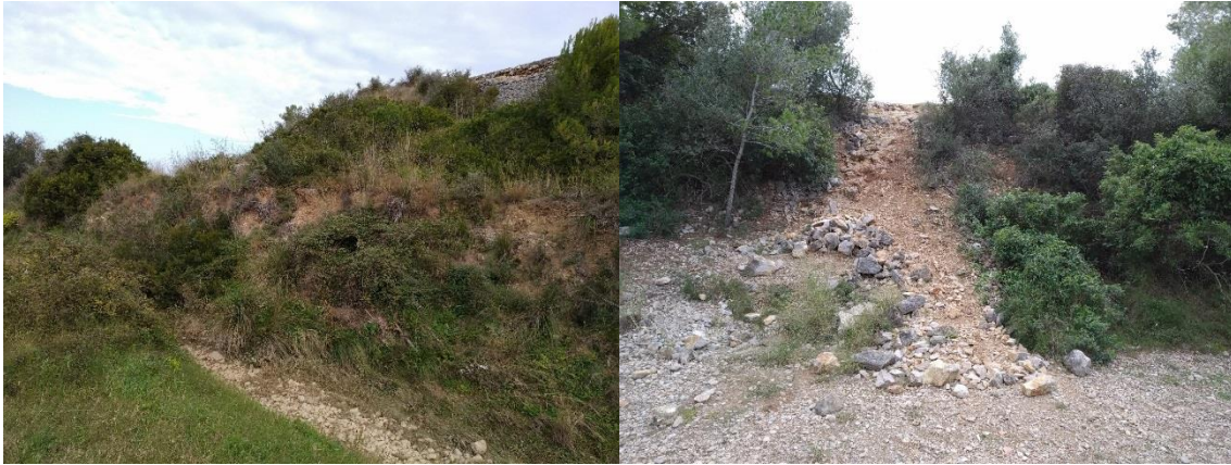
Fig. 25. Evidències de petites instabilitats en la part exterior del revolt peraltat W
