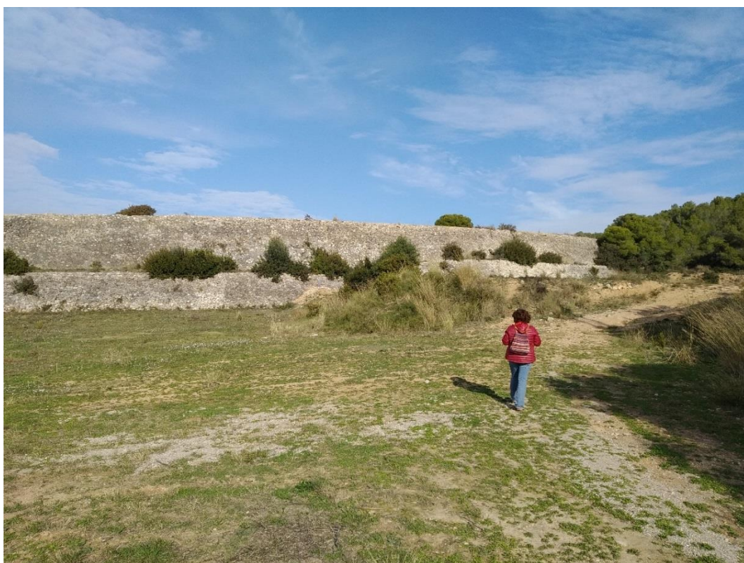
Fotografia 7. Mur de Pedra(contenció del Peralt en la zona SE del circuit).
