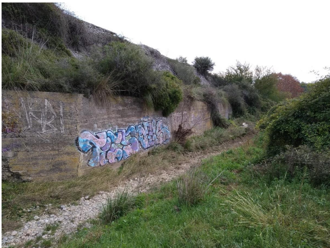
Fotografia 2. Mur de contenció a la riera
