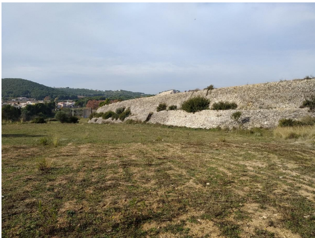
Fotografia 8. Mur de Pedra(contenció del Peralt en la zona SE del circuit).
