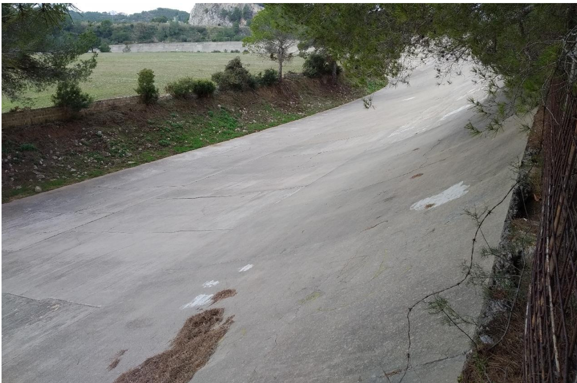
Fig. 28. Detall de la part pavimentada del circuit on s'observen les plaques de formigó
