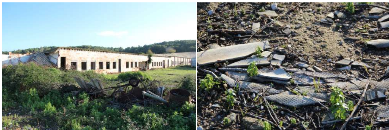
Imatge 12. Presència de residus i restes d'amiant
