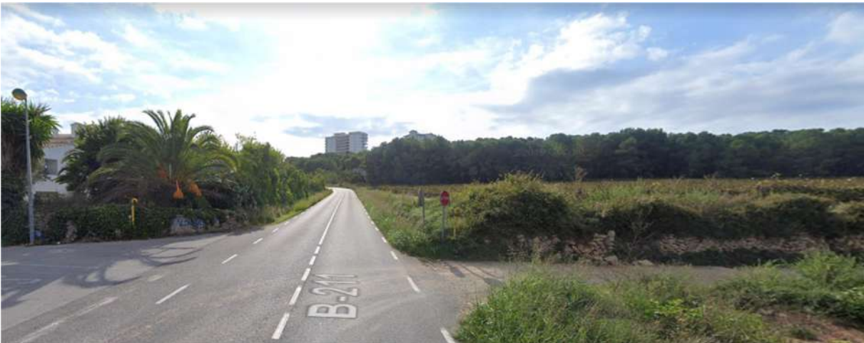
Carretera C-2111 a l'alçada del camí actual de l'entrada nord de l'Autòdrom de Terramar
