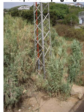
Torre pont càmping Sitges
