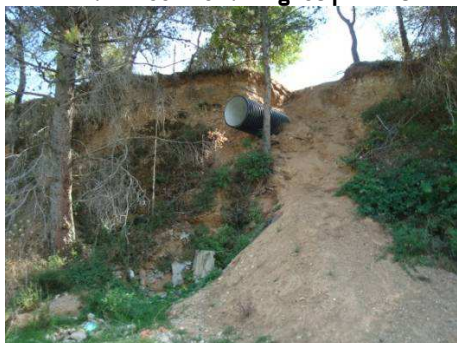
Punt d'abocament d'aigües pluvials
