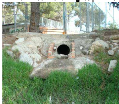
Punt d'abocament d'aigües pluvials
