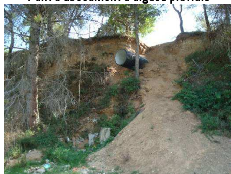
Punt d'abocament d'aigües pluvials
